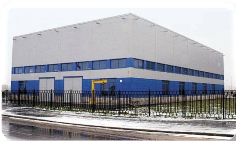
**Очистные сооружения поверхностного стока п. Осиновая Роща** – это сооружения подземного типа, предназначенные для механической очистки и обеззараживания поверхностных сточных вод.
